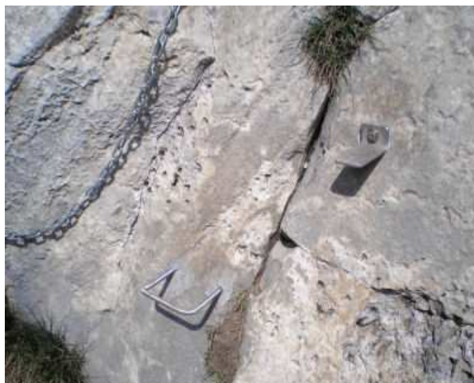
Escalones de acero facilitan el último esfuerzo
